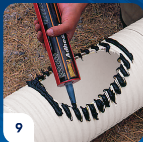
9 Aplique el adhesivo en los valles de la tubería, alrededor del hueco y espárzalo con espátula hasta cubrir las crestas.
