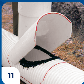
11 Coloque la silla sobre la tubería siguiendo las marcas y haga presión sobre ella.
