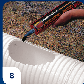
8 Presione lentamente el tornillo hasta que el adhesivo llegue al tope de la boquilla.
