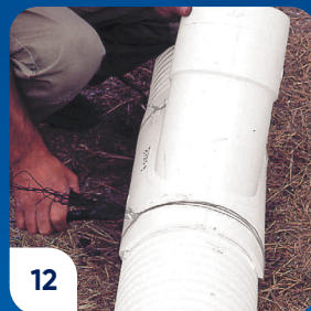
12 Monte las abrazaderas o cordón de alambre en los extremos de la silla y ajústelas firmemente.
