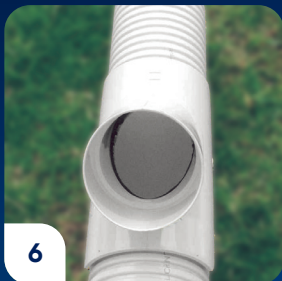
6 Haga lo mismo en la superficie de contacto de la silla. Deje secar mínimo durante 5 minutos.
