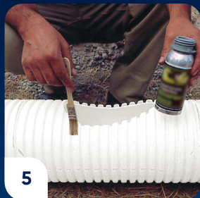
5 Limpie la tubería con estopa. Aplique limpiador sobre las crestas de la tubería, en una longitud de 3 cm. del borde a partir del contorno del hueco.
